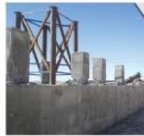
پروژه سرزمین ایرانیان اتصال سازه فلزی به بتنی پرند
